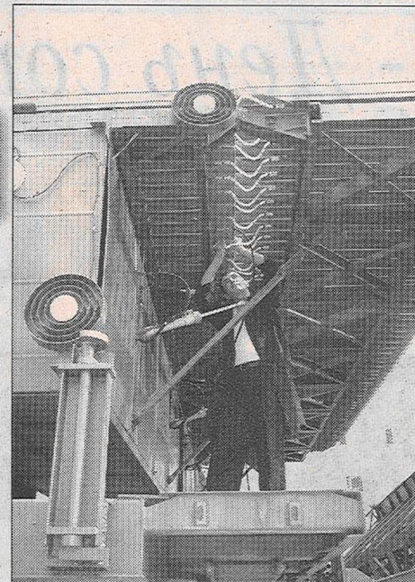
• Завершается монтаж антенны.
